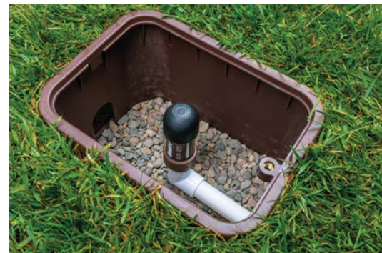
Entlüftungs-/Druckausgleichsventil Installiert
